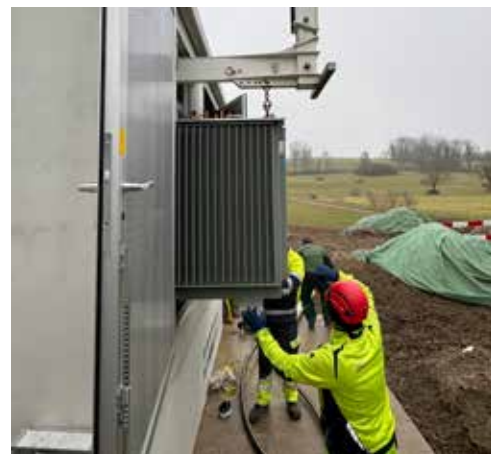
Der neue Transformator wird in die Kabine eingeschoben und einige Tage später, Anfang Februar 2025 erfolgt die Inbetriebnahme.
